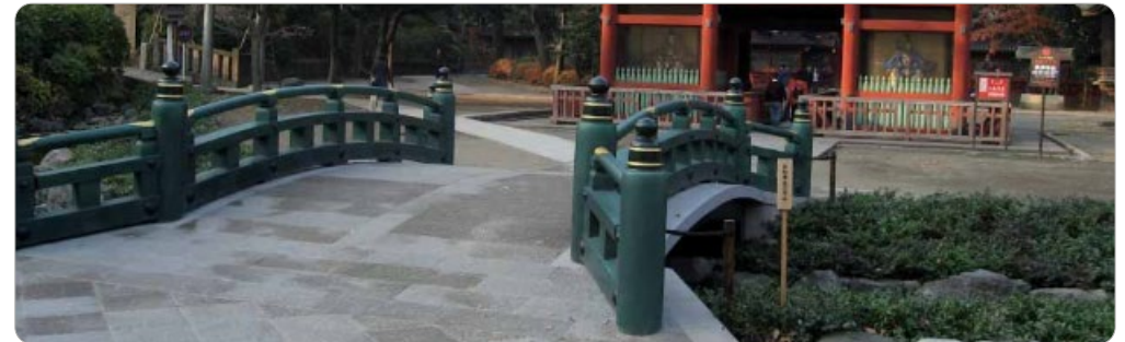
Brücke zum Nedujinja-Schrein mit nichtrostendem Bewehrungsstahl AISI 410 (EN 1.4006) (Foto: JSSA)
